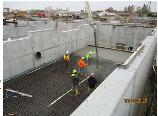
VLR 5 Elevated Slab Concrete Pour
