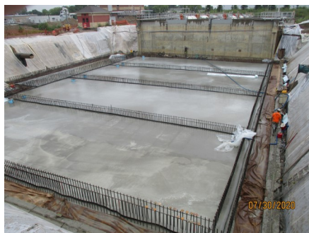
VLR concrete night pour complete
